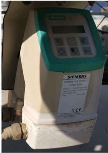
*Figura 3 - Trasmettitore SIEMENS SONO 3000*
