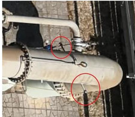
*Figura 1 - Installazione del sensore di flusso ad una traccia*
